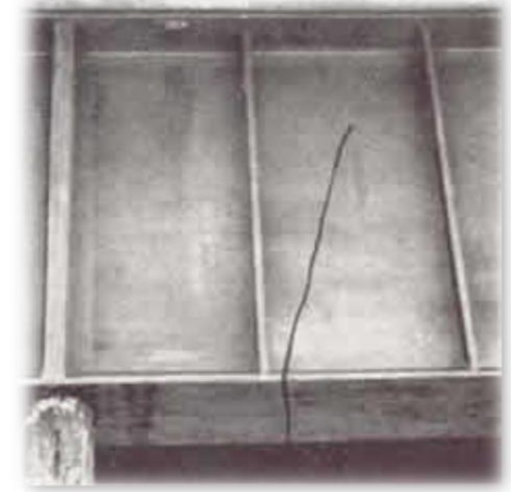
Köprü ana kirişinde kırılma
